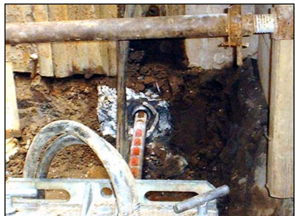
Bild4 Das Betonmesser kurz vorm Durchbruch
